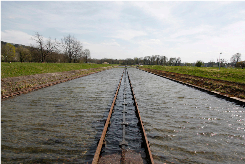
1.18. ábra: Talajvízdúsító műtárgy az Elba folyó mentén, Drezdában (a szerző szerkesztése)
