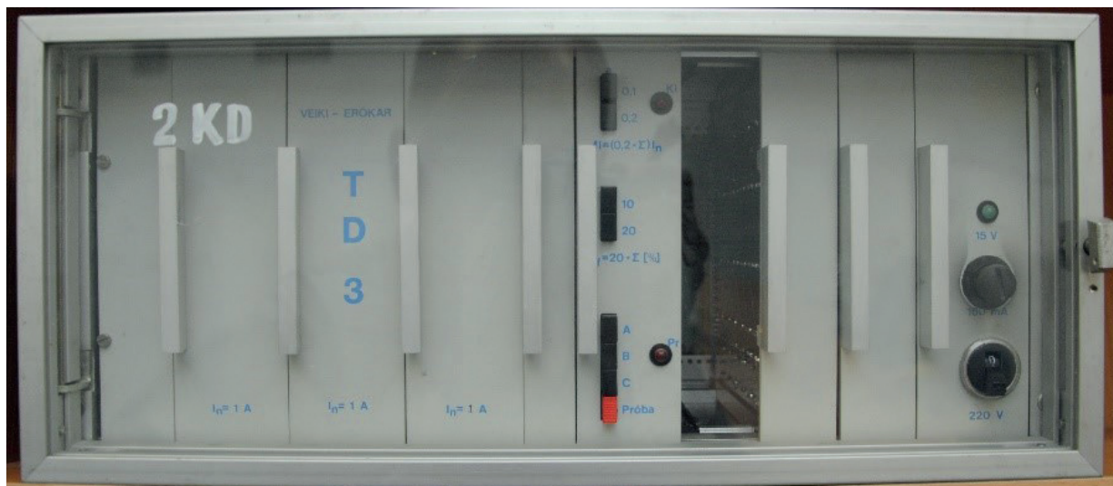
9. ábra – Elektronikus működési elvű védelmi és automatika készülék
