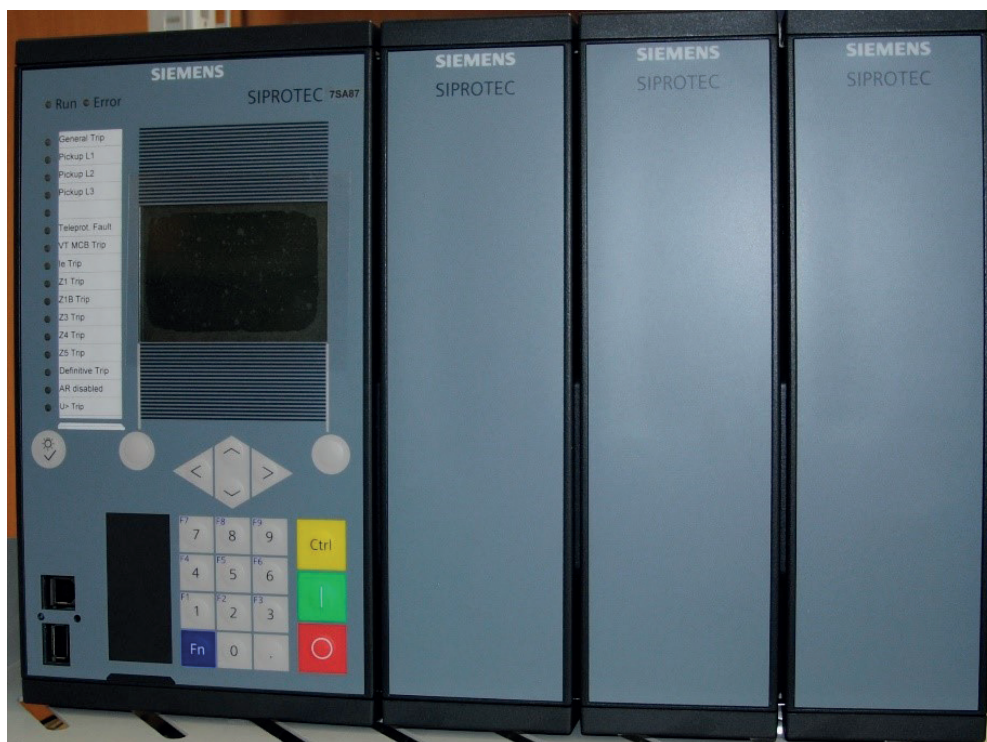
13. ábra – IEC 61850-es IED eszköz
