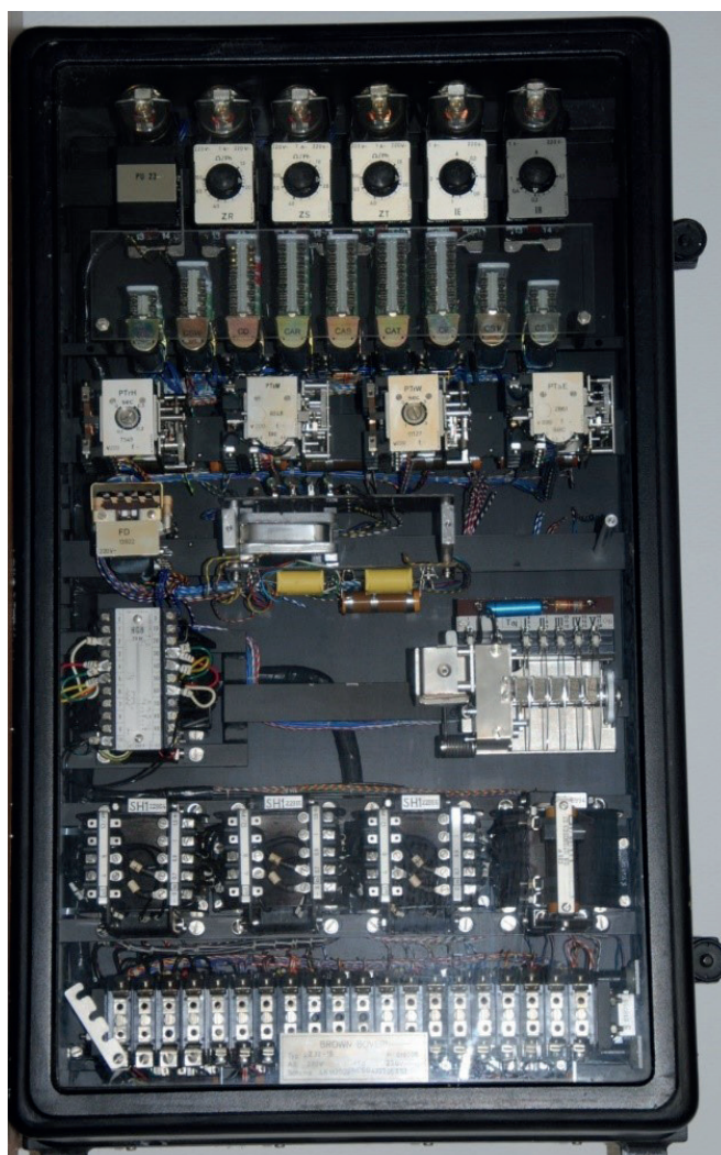
8. ábra – Elektromechanikus védelmi és automatika készülék
