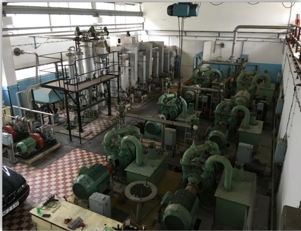
8. kép A barokamra épületének alsó szintjén elhelyezkedő levegőszűrők és kompresszorok (a szerző felvétele)
