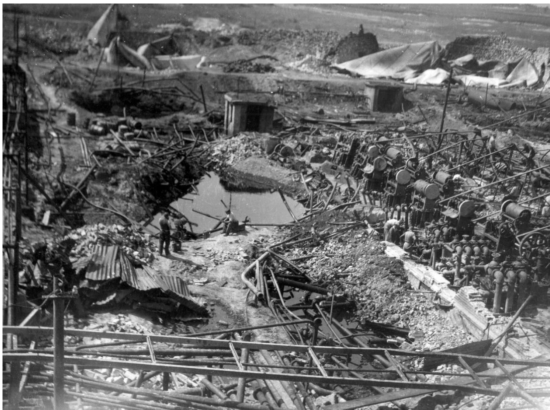
39. ábra A Vacuum Oil Co.Rt. almásfüzitői kőolaj-finomítójának lerombolt központi szivattyúháza az 1944. augusztus 9-i légitámadás után (Magyar Olaj- és Gázipari Múzeum)
