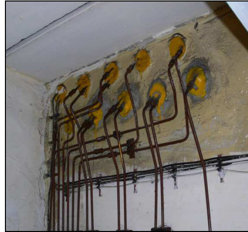
28. számú ábra: Elektromos kábelek és csővezetékek gáztömör fal átvezetése [44]
