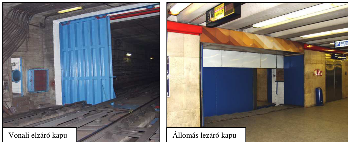
27. számú ábra: Vonali és állomás lezáró kapuk félig zárt helyzetben [44]
