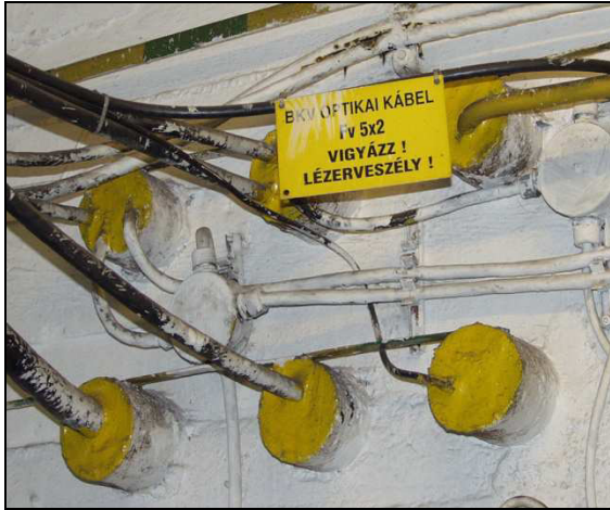
28. számú ábra: Elektromos kábelek és csővezetékek gáztömör fal átvezetése [44]
