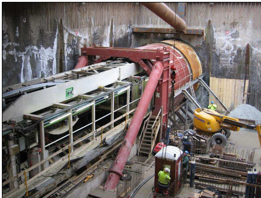
18. számú ábra: Nyitott homlokmeztámasztású pajzs az M4-es metró építésénél [47]
