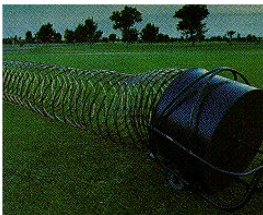
21. számú ábra: Dróthenger telepítése konténerből 105
