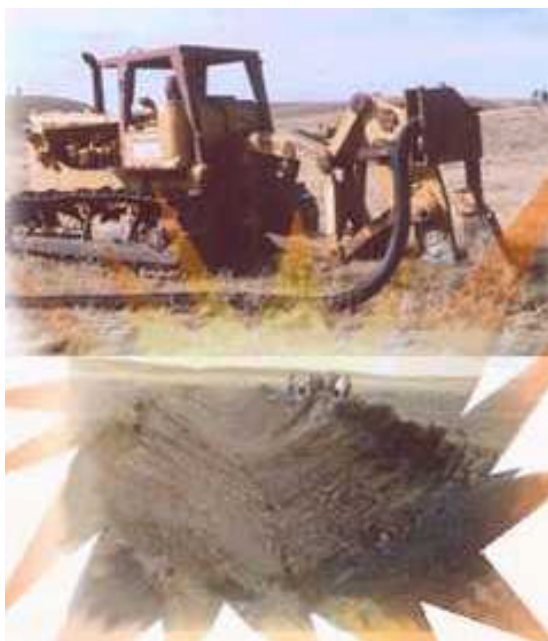
20. számú ábra: Harckocsiárok folyékony robbanóanyaggal történő robbantásának előkészületei és eredménye 104
